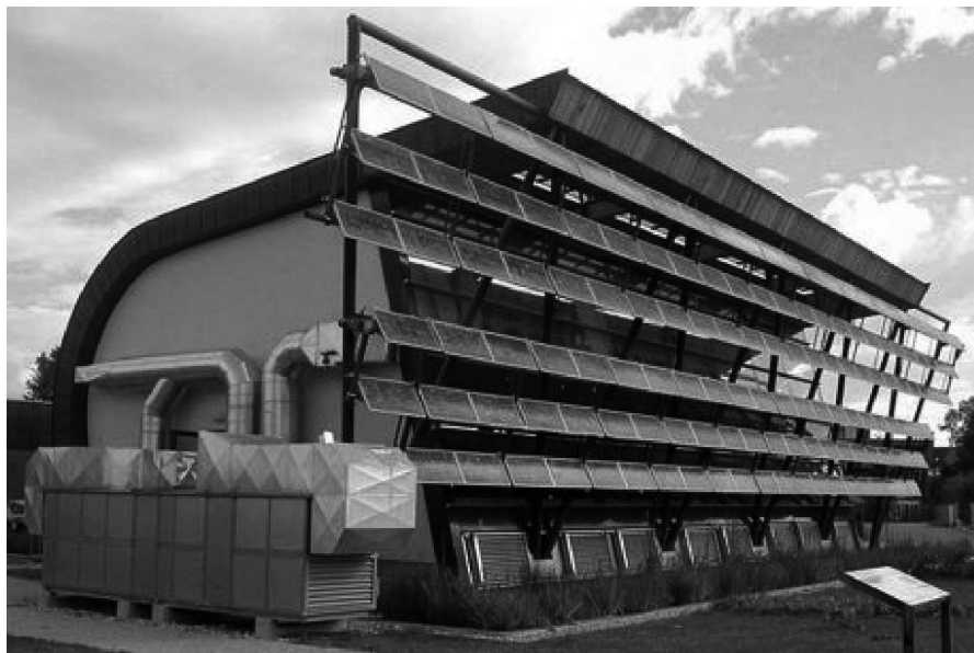
Obr. č. 4: Adsorpční chlazení přednáškové a zasedací budovy v Ekoparku Hartberg (Štýrsko, Rakousko)
